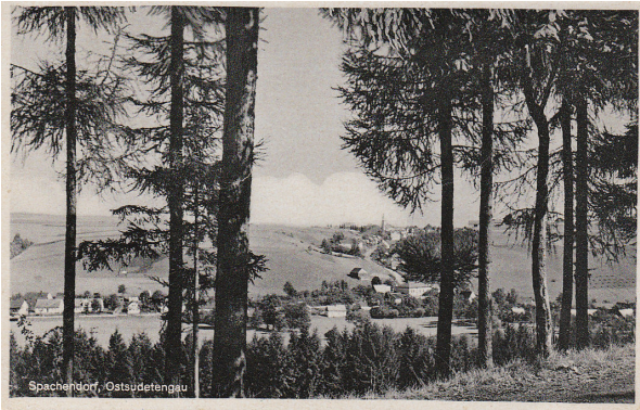
Zaniklá vesnice Leskovce nad Moravicí (Spachendorf)
